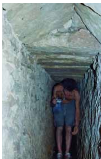
Galería principal 1992 El techo pasa a ser plano.
