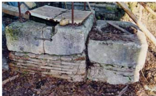
Detalle del pozo y los grandes bloques de piedra que lo caracterizan. 21.01.2005
