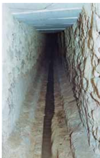
Galería principal 1992 Techo plano y pared reforzada en la parte baja.
