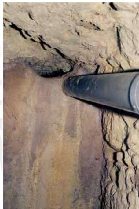
Principio alcabor, pared y tubería en el nacimiento, para que salga a un nivel más alto. 12-08-2012
