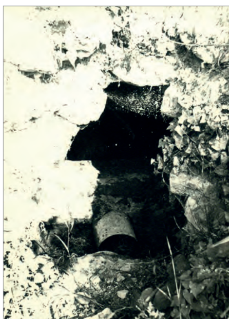
Alcabor del Olmar de Abajo. Boca de entrada y tubería
