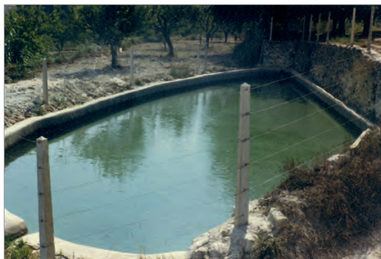
Balsa de riego de la Caseta Ferre.
