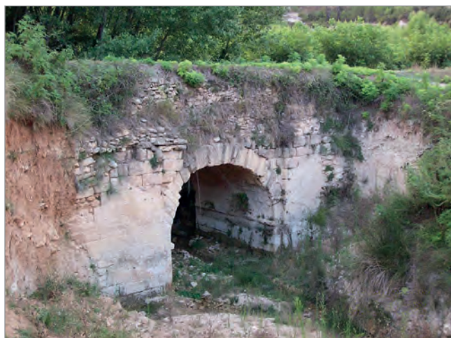
Figura 4. Pont andalusí de la Frontera
