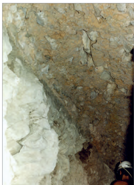
Detalle del techo
