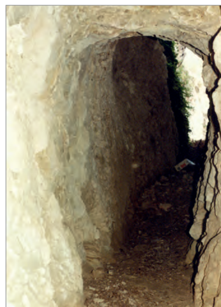
Alcabor desagüe, boca de salida
