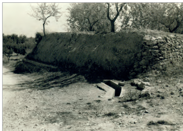
Acequia L'Ambeurà. Después de la reforma
