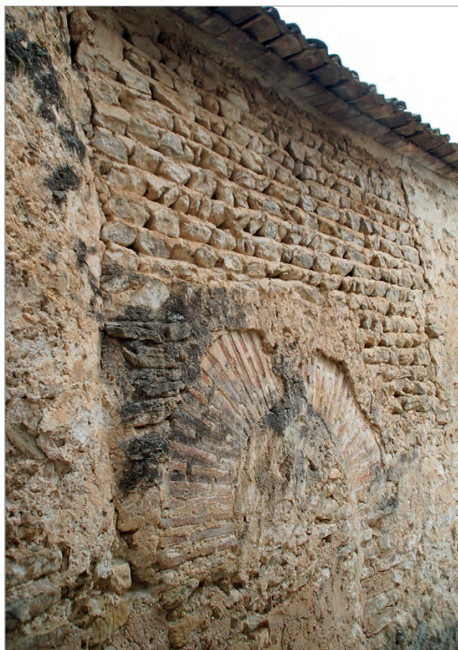
Figura 2. Paret d'una casa àrab prop de la Porta de Sant Joan (arc d'entrada tapiat)
