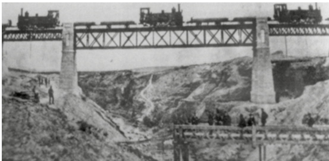
Proves de càrrega al pont de Biar sobre el Vinalopó, amb 3 locomotores Hartmann i 6 plataformes (arxiu D.F. Laosa, Villena)
