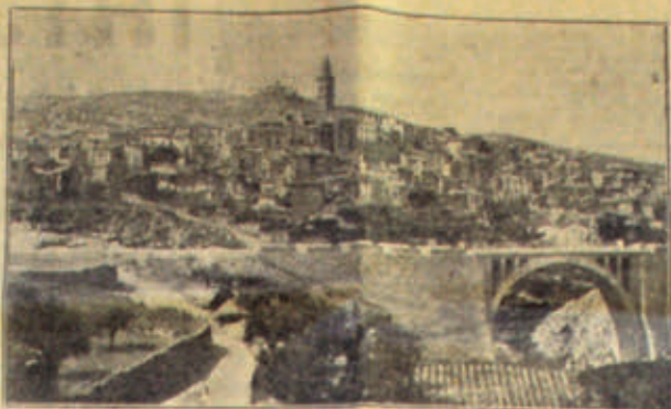
Desde el punto de vista de Santa Cruz, se ve a Bocaliente, en la zona de la zona.
