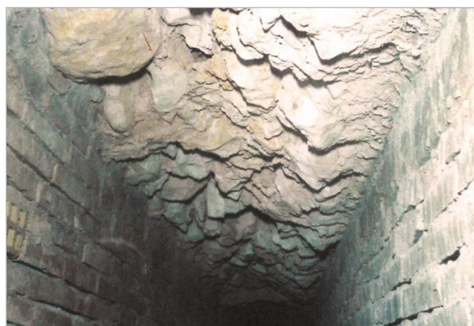
Detalle de la bóveda y paredes de ladrillos del Alcabor. En el año 1991.
