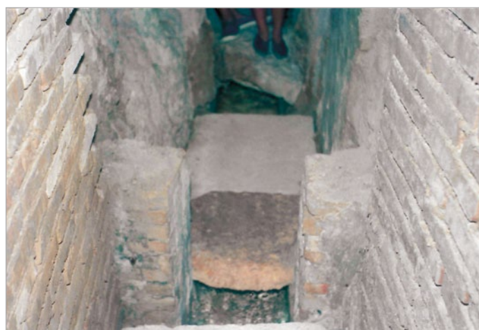
Detalle Alcabor y acequia. Paredes de ladrillos. En 1991.
