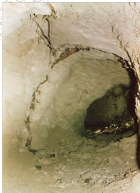
Dos detalles del alcabor del "Rec de les Solanetes". En ambas fotos se ven perfectamente los derrumbes que hay en él, el de arriba es bastante grande. La tubería va cubierta. El día 09-06-2002.
