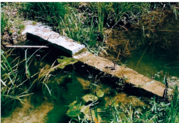
Dos fotos de diferentes años de la presa/azud que conduce el agua por la tubería al alcabor y balsa del “ Rec de les Solanetes ”. El día 26-06-2002. Fotos: R. Doménech
