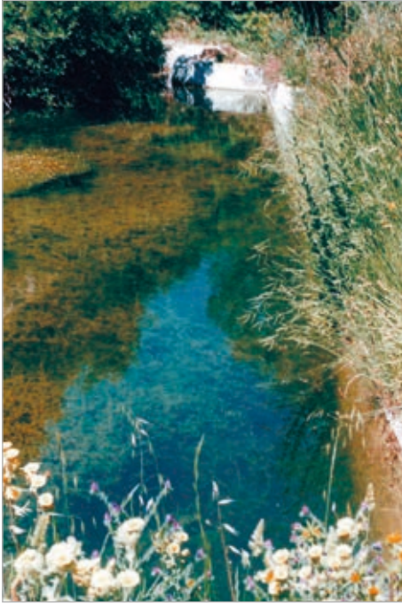
En la actualidad (2023) se encuentra vacía por unos derrumbes en ella.
