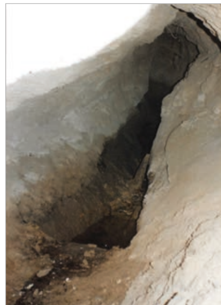
Otro detalle del alcabor. A este punto llega la tubería cubierta. En el año 1987.
