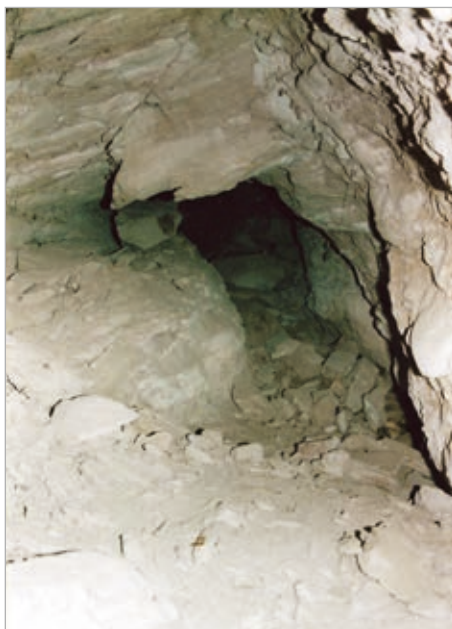
Dos detalles del alcabor del "Rec de les Solanetes". En ambas fotos se ven perfectamente los derrumbes que hay en él, el de arriba es bastante grande. La tubería va cubierta. El día 09-06-2002.
