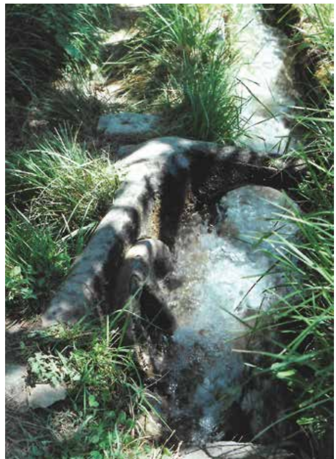
Parte superior del "Pont de la Noguereta, el Pas de l'Aigua". (6) En la actualidad se utiliza como acueducto, en 1991 (Uno de los brazaes pasa por este puente, en hoja aparte más datos). El 9-8-1998.
