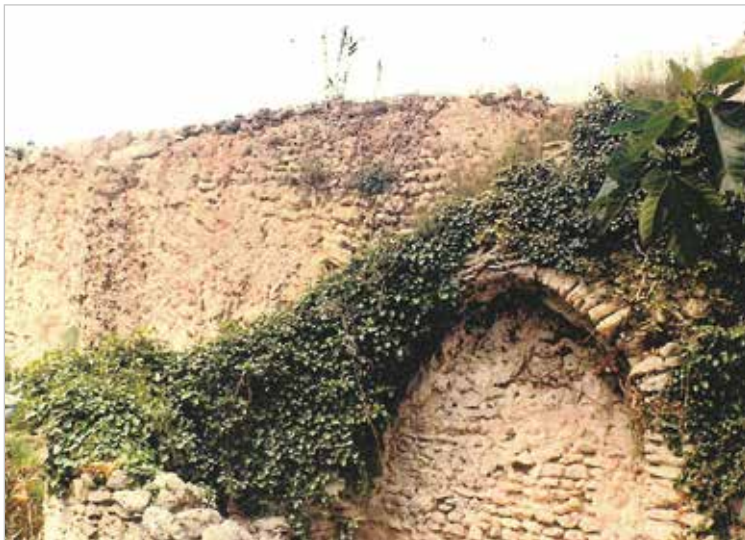
Lo poco que queda del molino nuevo o del Cipreret, construcción por donde va la acequia que conducía el agua al CUP. Con un arco de medio punto. Fotos año 1981.
