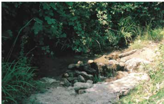
Detalle de la presa/azud. Nace otra acequia que llega hasta la balsa del Riego de la Alquería. En el año 1991.
