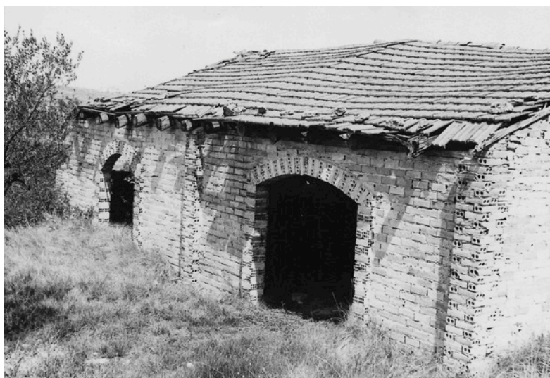
Bocairent, restos del edificio del Tejar de Galbis. En 1980.
