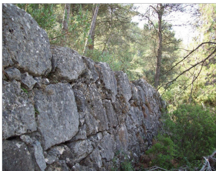
Detall del mur de pedra en sec
