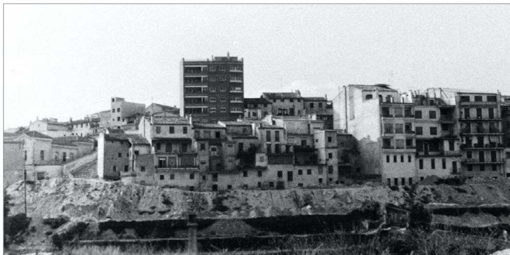
Aspecte de l'obra en fase d'execució - c.1973
