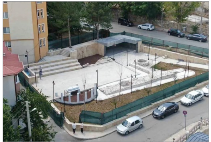
Restauración finalizada en julio de 2024. Fuente: mersinhabermerkezi.com
